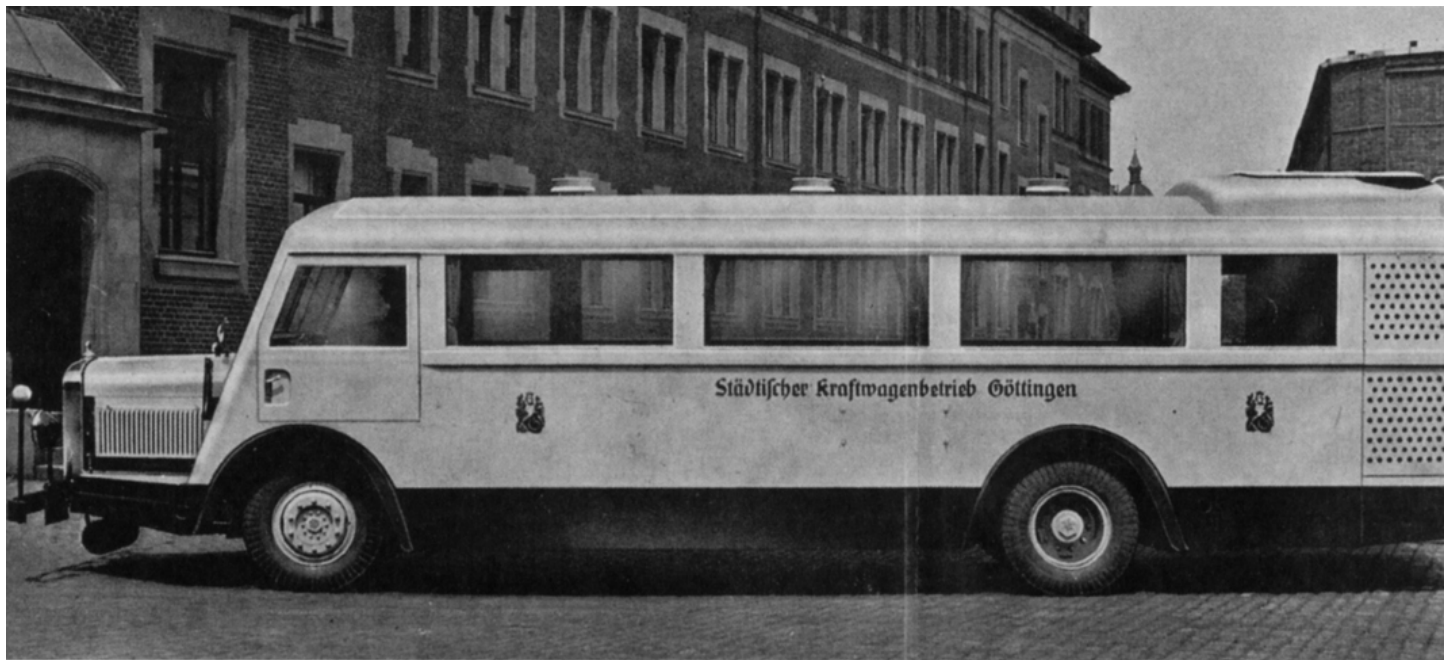
Bild 1: Abdruck aus Kundeninformation. Auf diesem Bild ist gut zu erkennen, daß die Holzgas-Anlage im Heck des Wagens verbaut war. Dort wurden auch die Holzvorräte gelagert. Mithin wurde die Hälfte der Plattform für die Holzgas-Anlage benötigt. Die sichtbaren Löcher dienten der Kühlung der Anlage..
